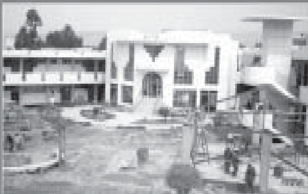
La Facultad de Derecho en proceso de construcción y estructuración de infraestructura
